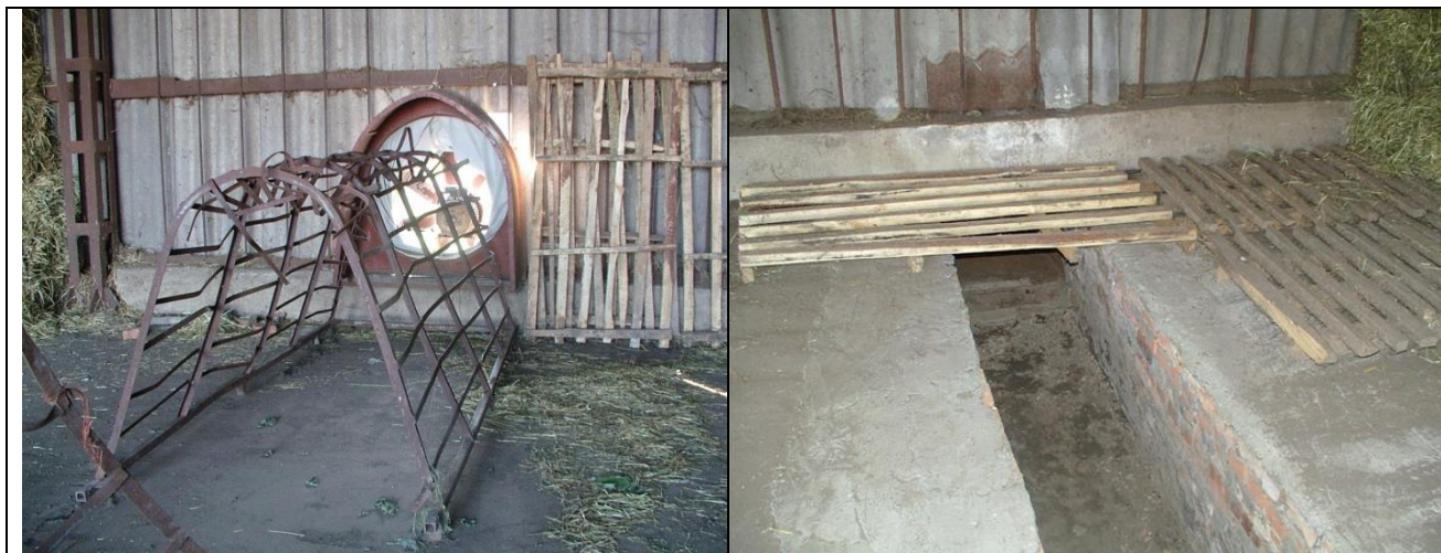
Рис. 5. Повітророзподільні системи: підлогова з металевим каркасом та підпідлогова з дерев'яними решітками
